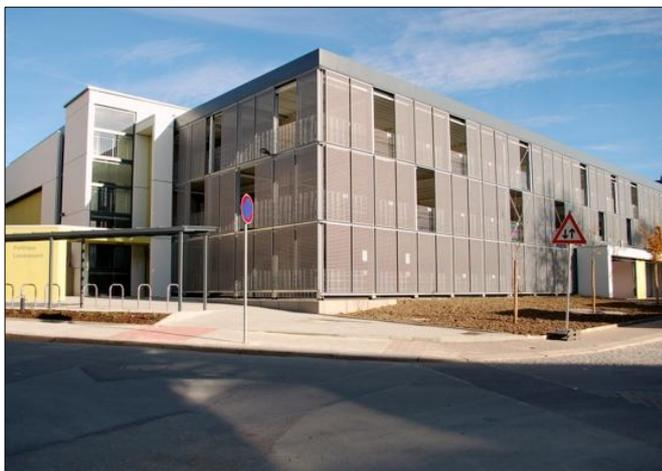
Das Parkhaus mit der Fassade aus farbigen Stahlbetonelementen, Schallschutzelementen und Aluminiumlochblech-Kassetten fügt sich harmonisch in die Wohnbebauung ein.
