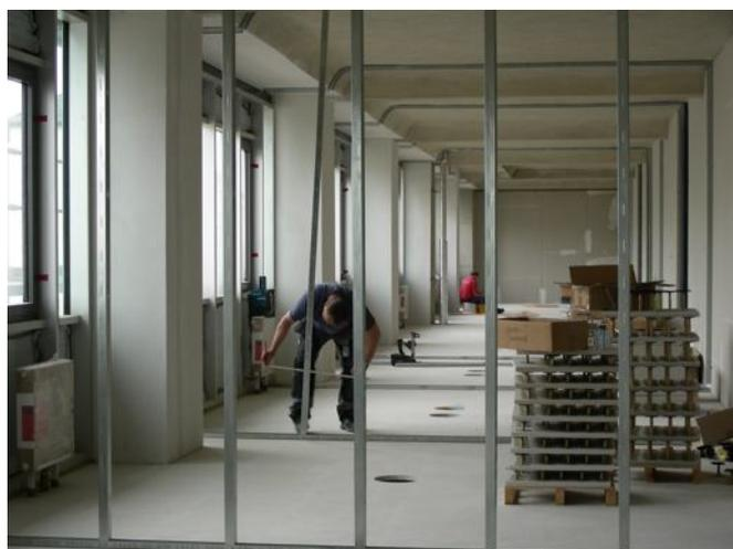
Die Hohlraumböden in den Räumen zur Forststraße sind hier schon installiert und es entstehen die Büroeinheiten in modularer Trockenbauweise.
