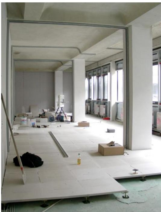
Die Hohlraumböden werden installiert und verdecken damit die auf dem Rohboden liegenden Kabel.
