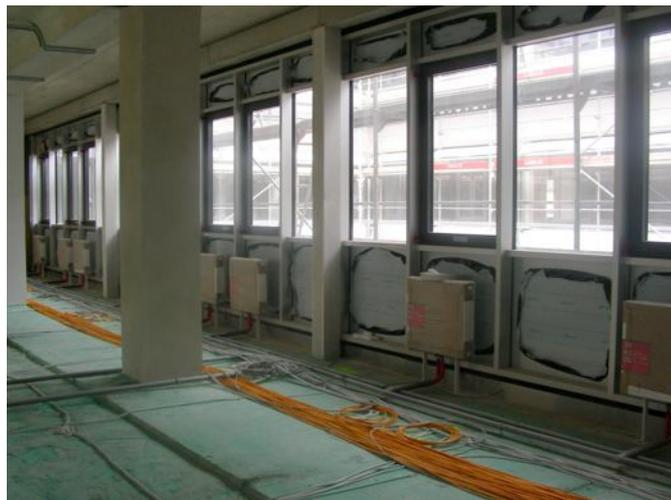
Die Rohinstallation ist abgeschlossen und fertig zur Hohlbodenmontage.
