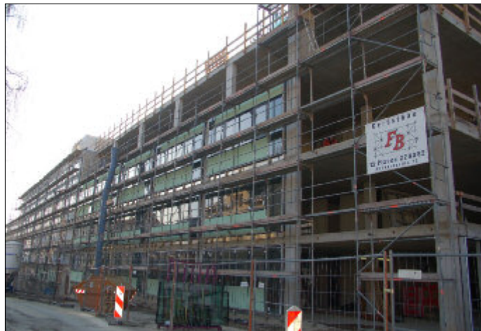
Der Baufortschritt am ehemaligen Hortenkaufhaus, dem künftigen Sitz der Landkreisverwaltung, ist nun auch zusehends an der Außenfassade wahrzunehmen. Schritt für Schritt wächst das Bauskelett im Bereich der Forststraße und der Rädelsstraße zum attraktiven Bürogebäude.
