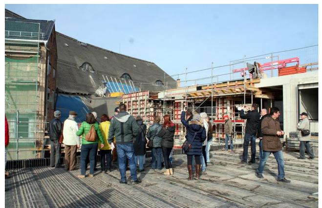
Das Dach des denkmalgeschützten Altbaus ist auf der Rückseite noch nicht fertig. Alte Pappschildeln werden durch neue ersetzt. Dieser Blick bietet sich von Flachdach des fertigen Neubauteils an der Forststraße.
