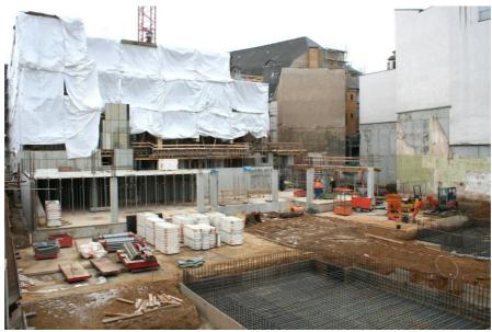
Im Vordergrund wird die Fundamentplatte für die Betonage vorbereitet (Ecke Ränisstr./Forststr. Wo die Platten lagern wird das Erdgeschoss gebaut.
