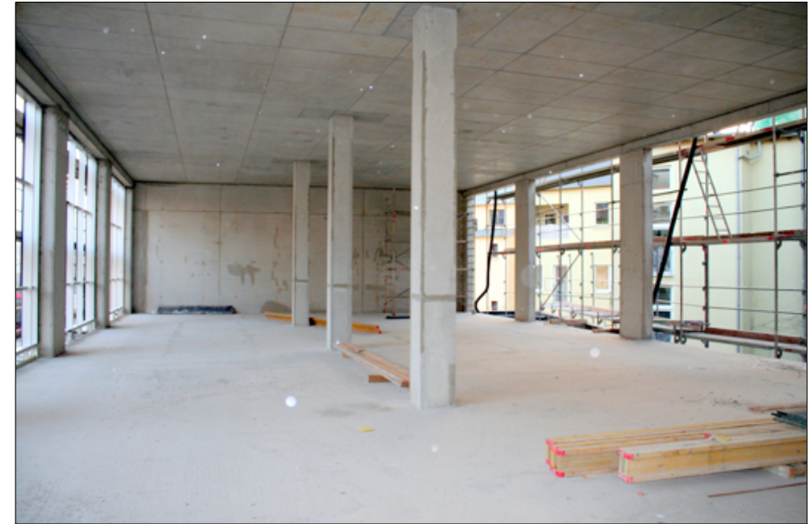
Blick in das 3. Obergeschoss des Neubaus zur Forststraße
