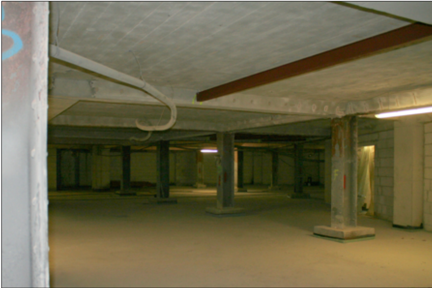
Der Keller im alten Gebäude zum Postplatz nimmt Gestalt an.
