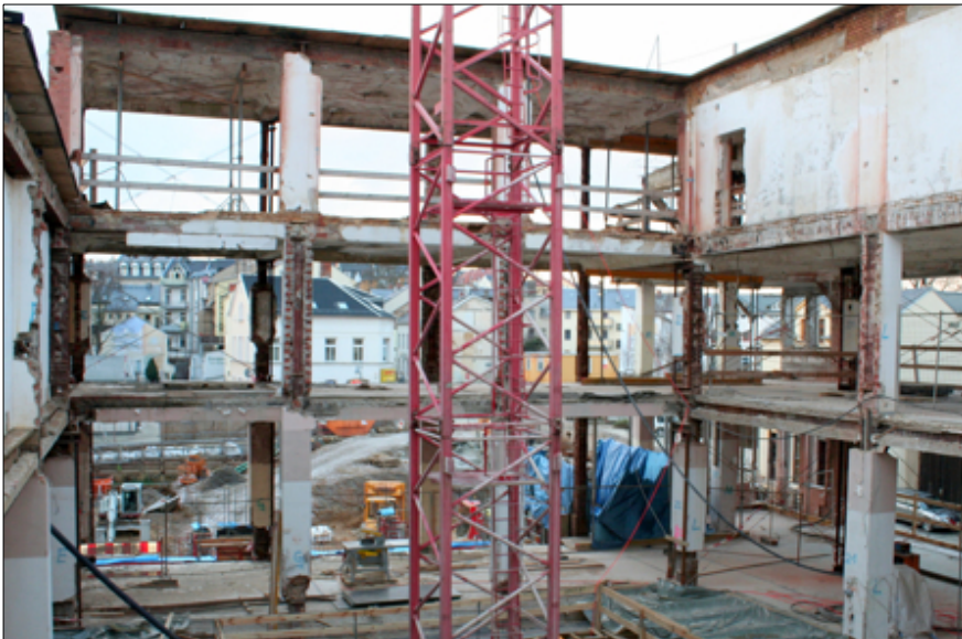
Blick in den späteren Innenhof, in dem jetzt noch der Kran steht.
