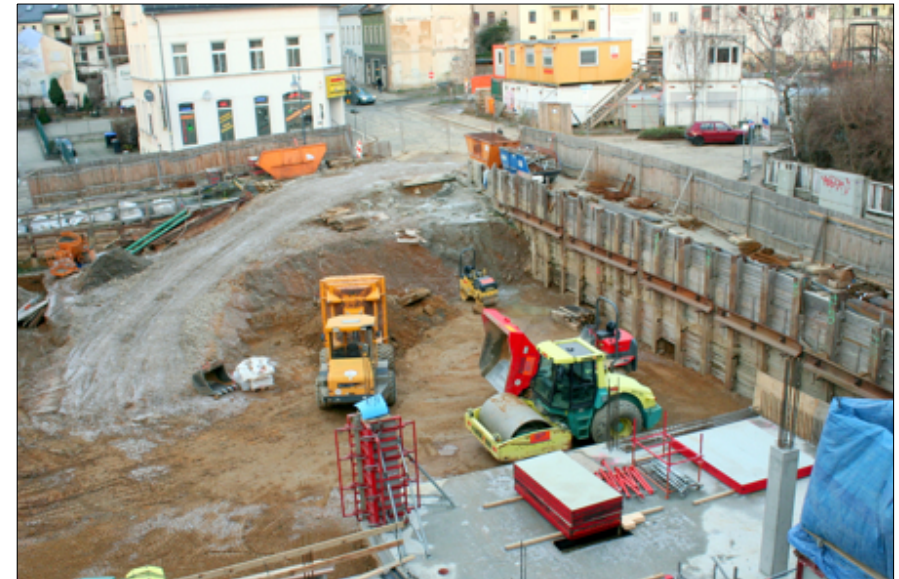
Blick vom entkernten Gebäude auf das Untergeschoss des Neubaus an der Rädelsstraße.
