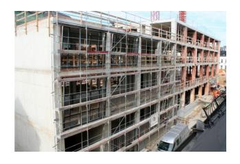
Oktober 2013: Die letzte Etage des Neubaus (Gebäude im Vordergrund) ist rohbauseitig komplett fertig. Es wurde mit der Montage der Fassadenelemente begonnen. Am nebenstehenden Gebäude wurde die letzte Decke montiert.
