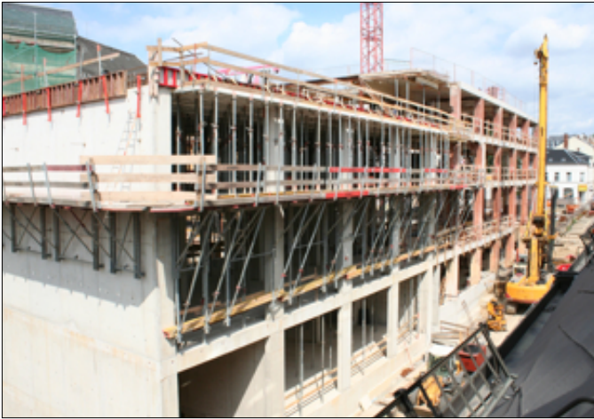
Baufortschritt des Neubaus an der Fortststraße
