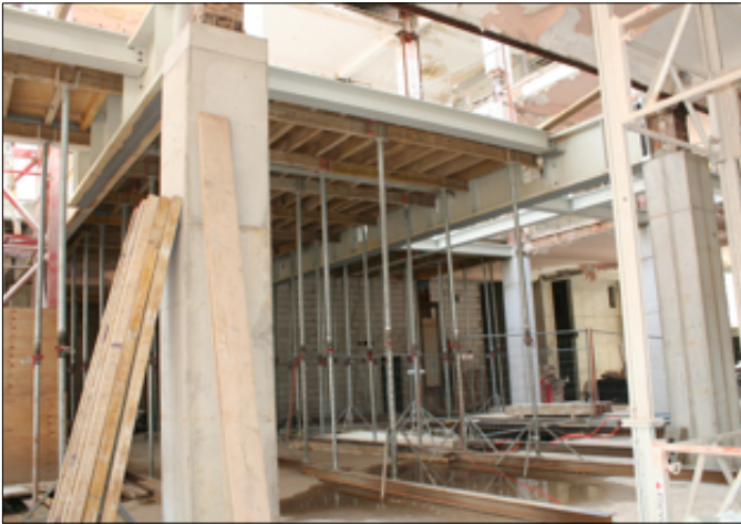
Die künftige Decke über dem neuen Sitzungssaal wird für die Betonage eingeschalt.
