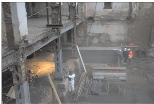
Sandstrahlarbeiten an einem Stützfuß im Kellergeschoss (Rostbeseitigung und Stütztüchtigung)
