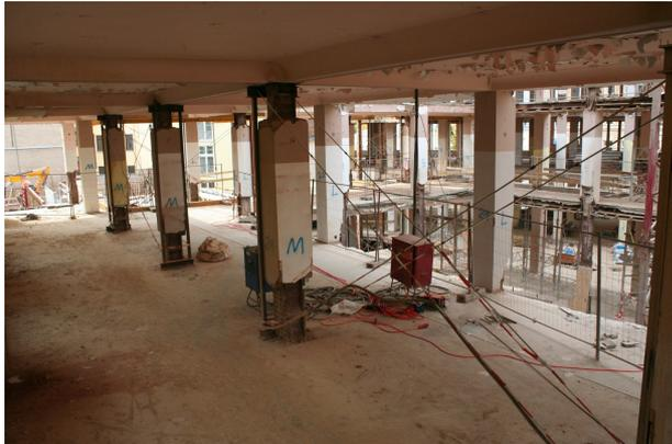
Stützfußsanierung im verbleibenden Stahlbetongerippe
