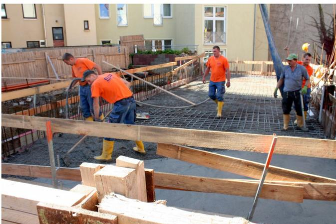
Betonage der Decke über dem künftigen Erdgeschoss für den Neubau an der unteren Forststraße
