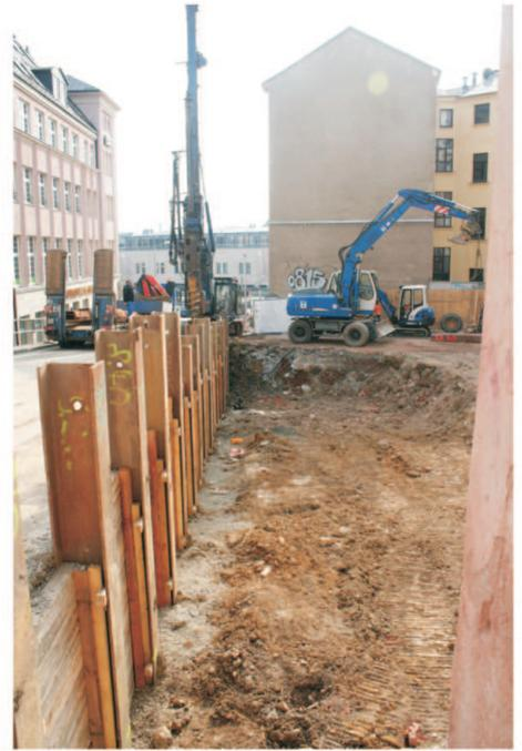
Verbauarbeiten - sie sichern die noch auszuhebenden Baugruben.
