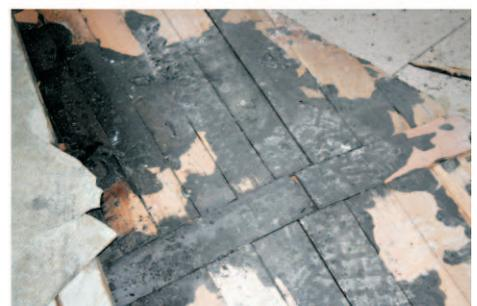
Durch den Fund von altem und schadstoffreichen Teerkleber unter dem Fußbodenbelag auf einer Fläche von rund 5000 m<sup>2</sup> verzögern sich die Arbeiten.
